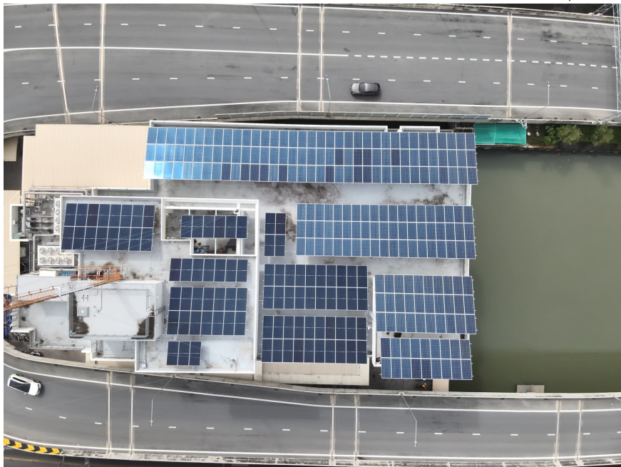
โครงการติดตั้งระบบผลิตพลังงานแสงอาทิตย์ ศูนย์ควบคุมประจิมรัถยา
