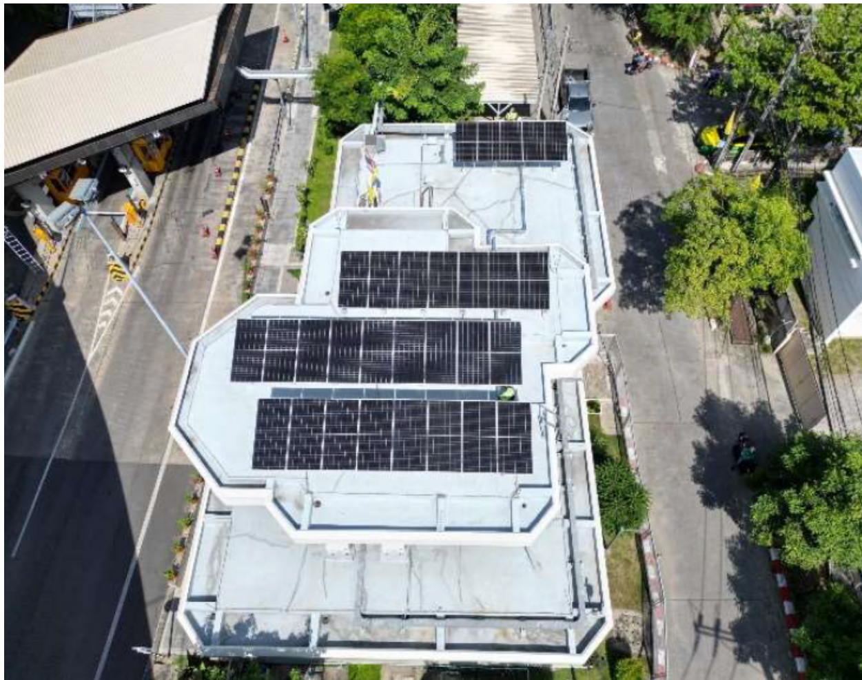
โครงการติดตั้งระบบผลิตพลังงานแสงอาทิตย์หลังคาอาคาร บริเวณอาคารด่านเก็บค่าผ่านทางพิเศษศรีรัช
