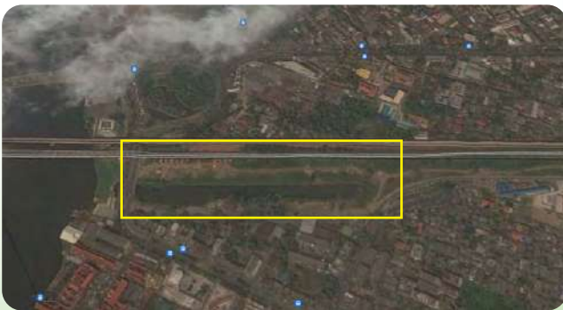
ก่อนการก่อสร้าง
