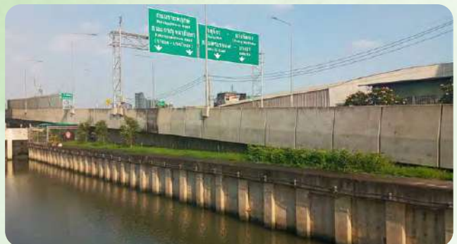
กำแพงกันดิน (Retaining Wall) บริเวณริมคลองซุง
